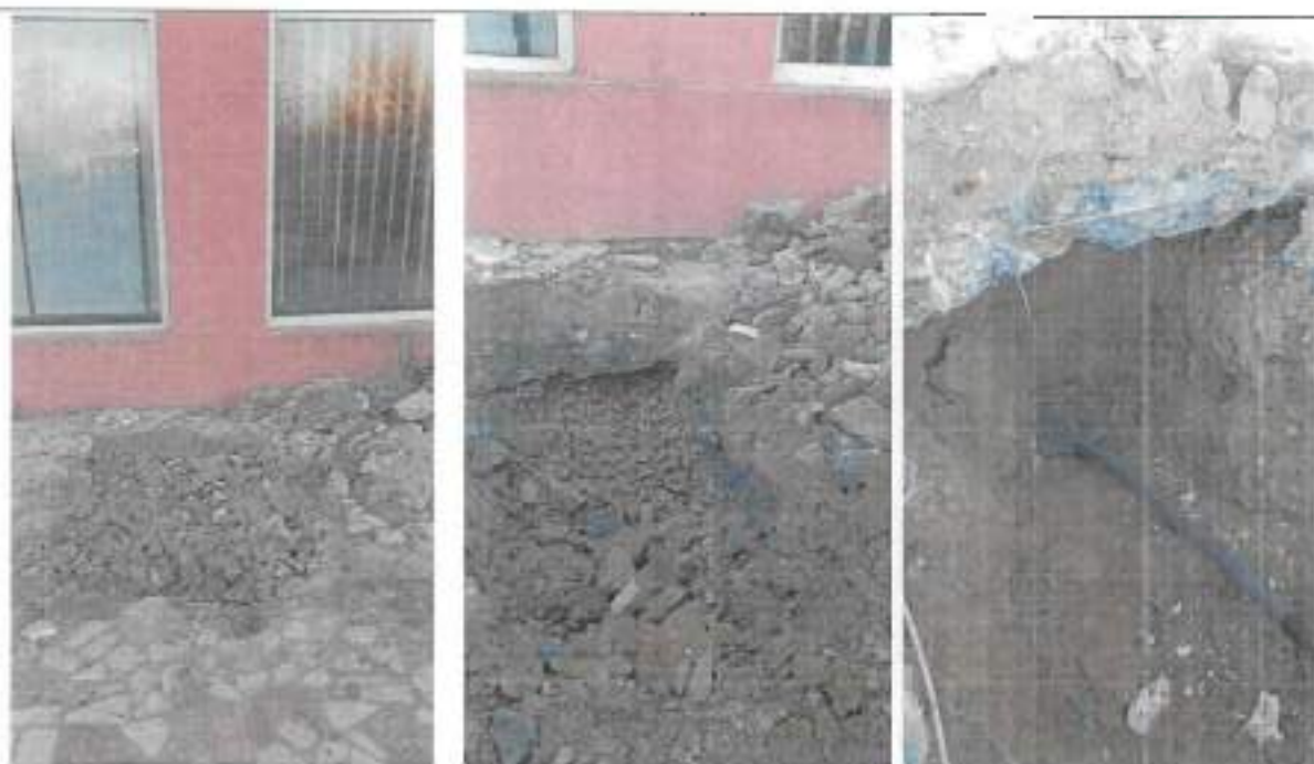
Detalii sondaj fundație
