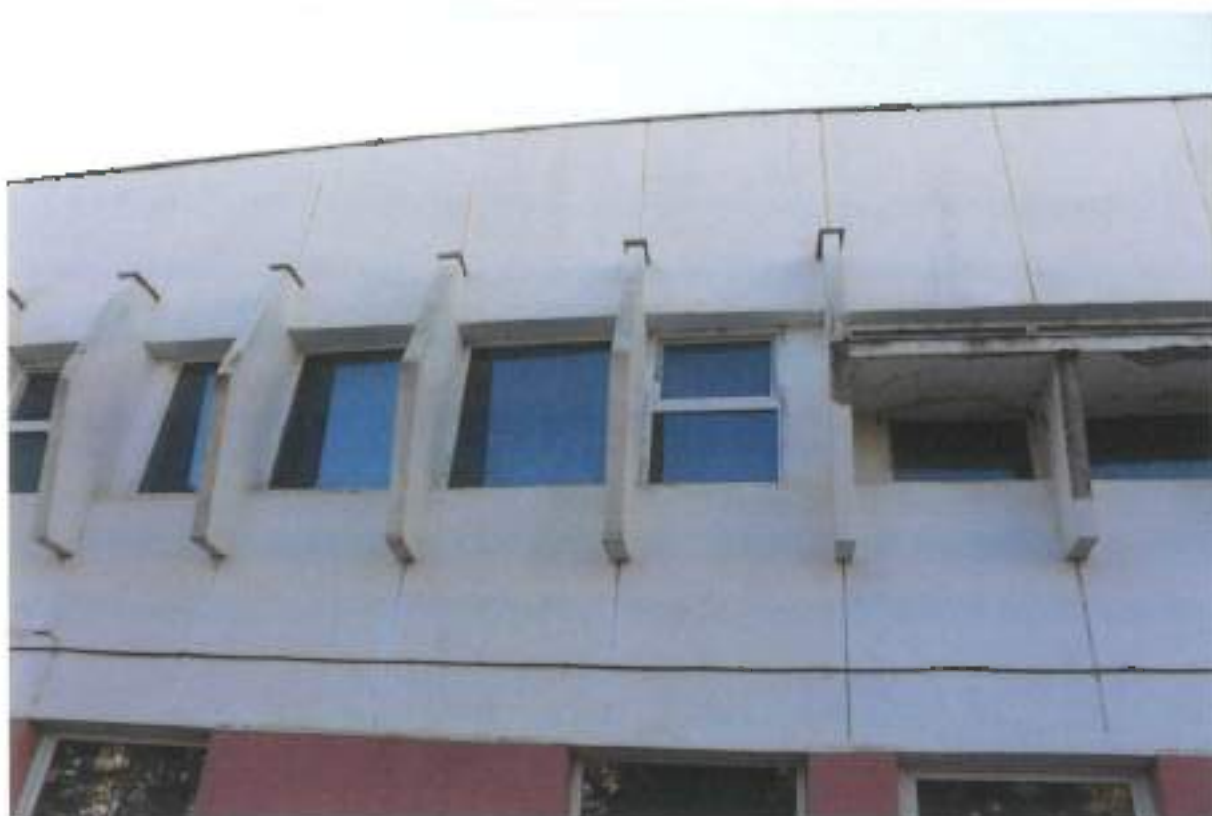
Foto 111 - Fațada laterala stanga
