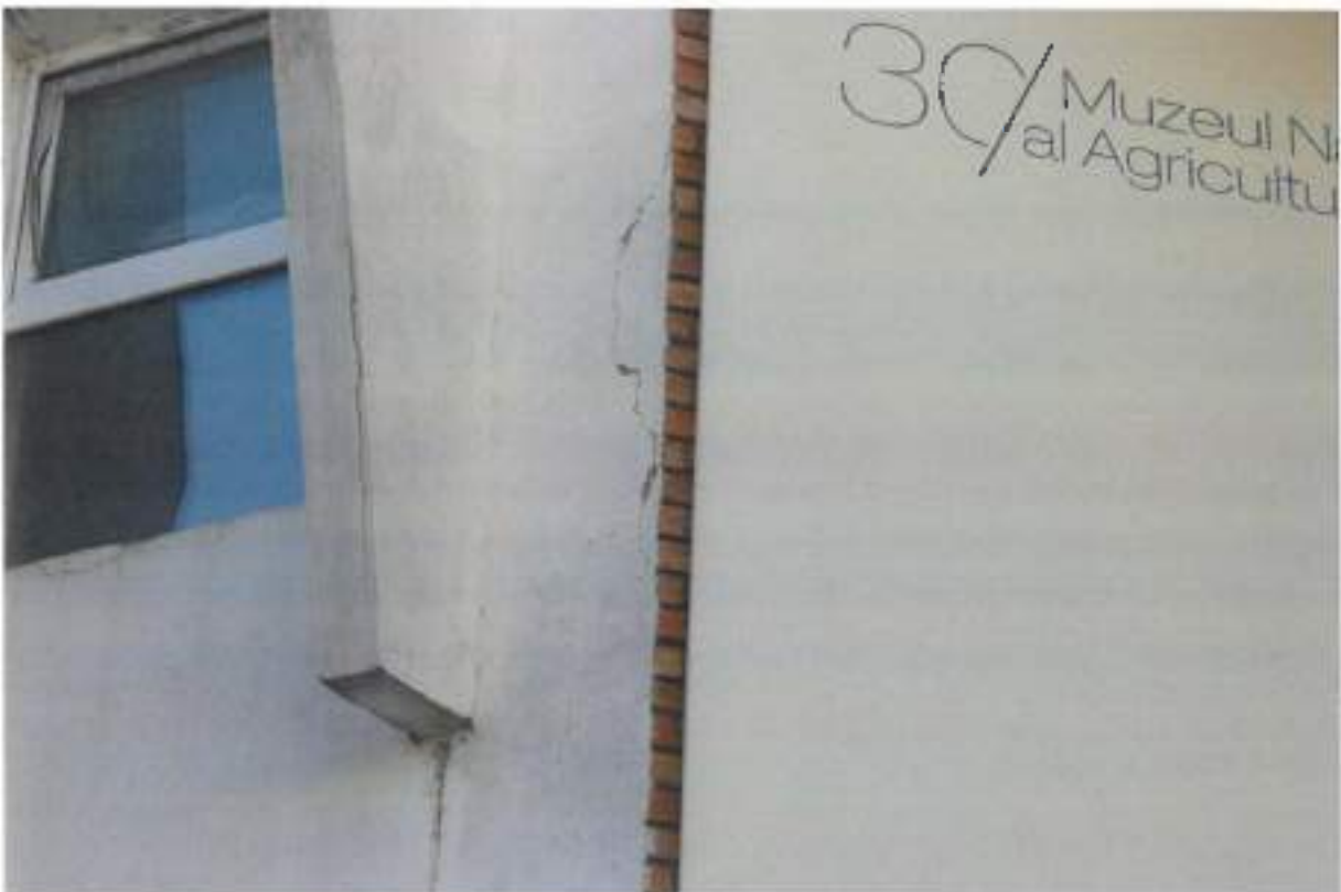
Foto 123 - Fațada laterală stânga
