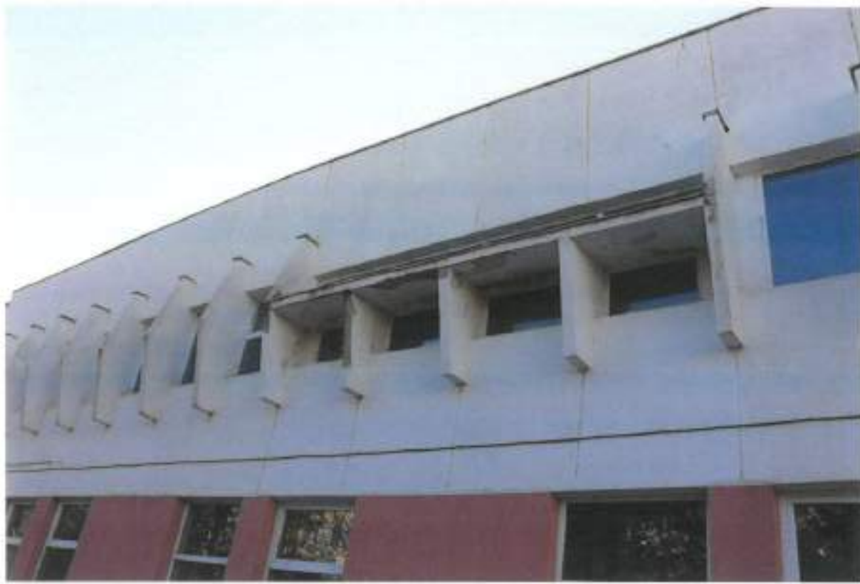
Foto 109 - Fațada laterala stanga
