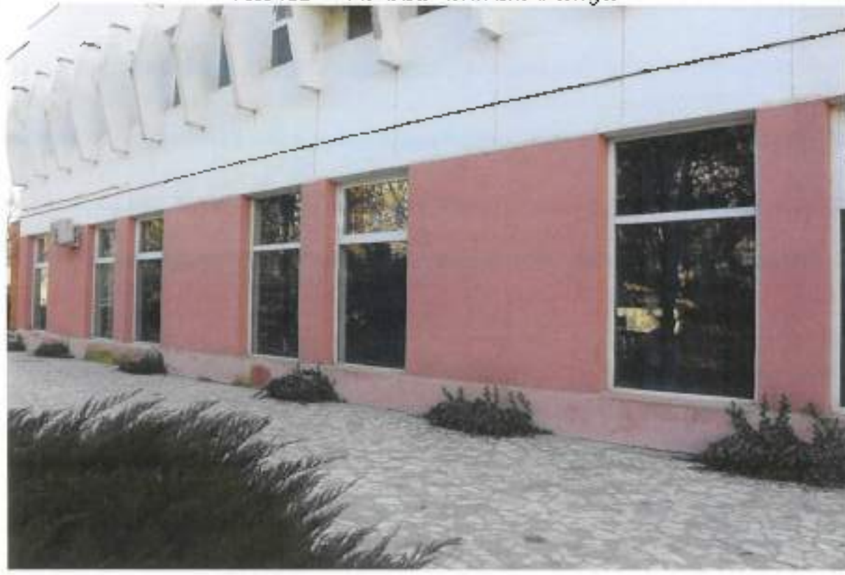
Foto 110 - Fațada laterala stanga
