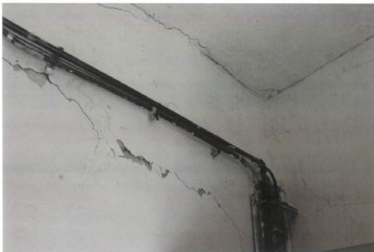
Foto 47 - Parter - Incapere panou electric general
