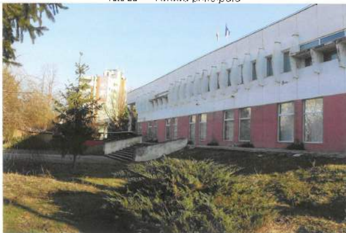
Foto B4 - Fațada principală
