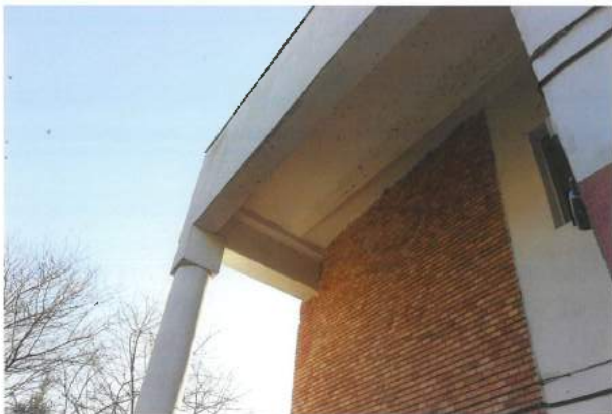
Foto 119 - Fațada laterală stângă
