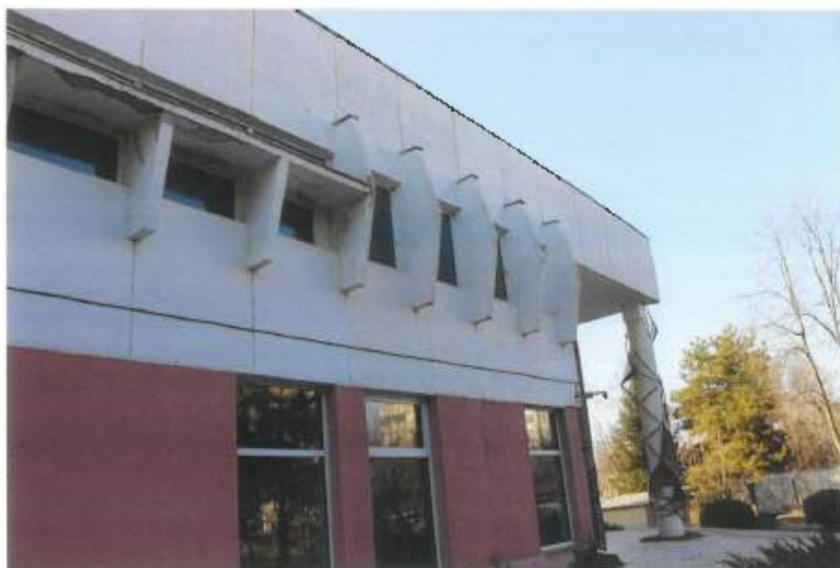
Foto 113 - Fațada laterală stângă
