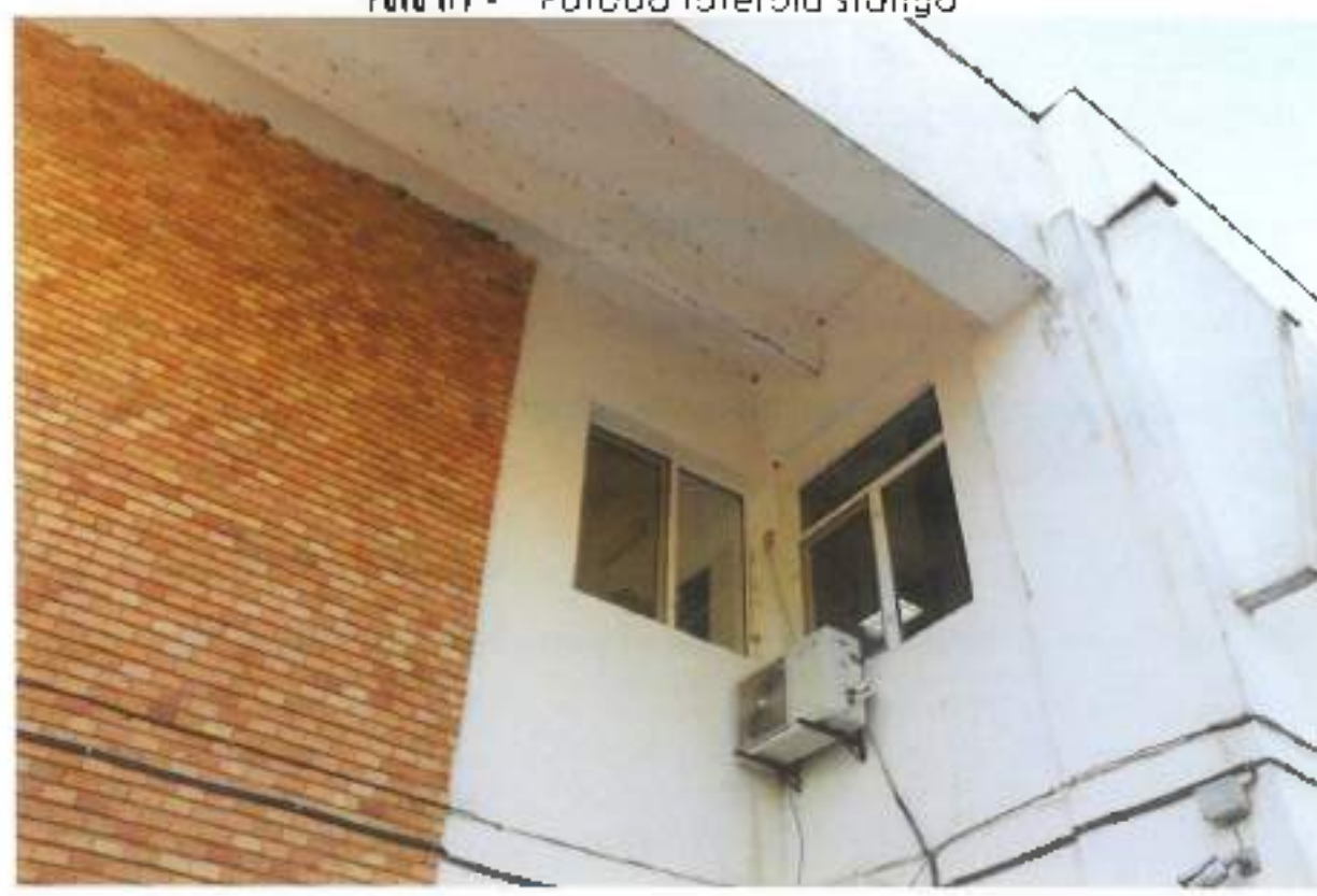
Foto 118 - Fațada laterală stânga
