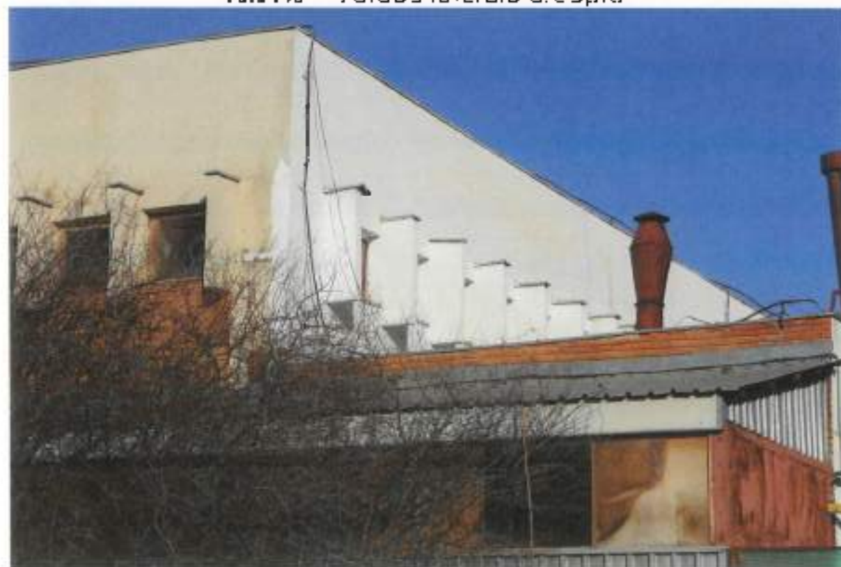
Foto 146 - Fațada laterală dreapta
