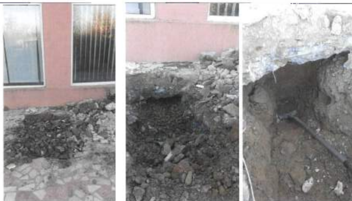
Foto nr. 7 - Detalii sondaj fundație
