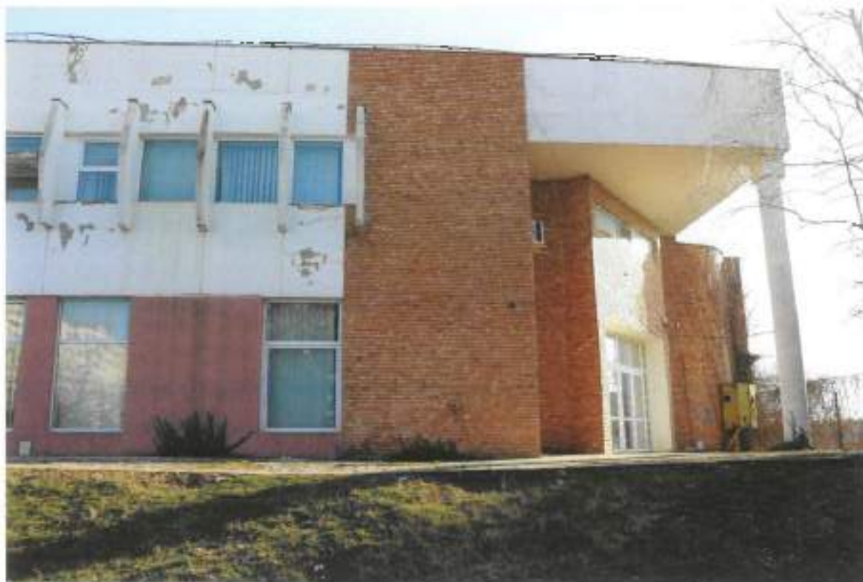
Foto B3 - Fațada principală
