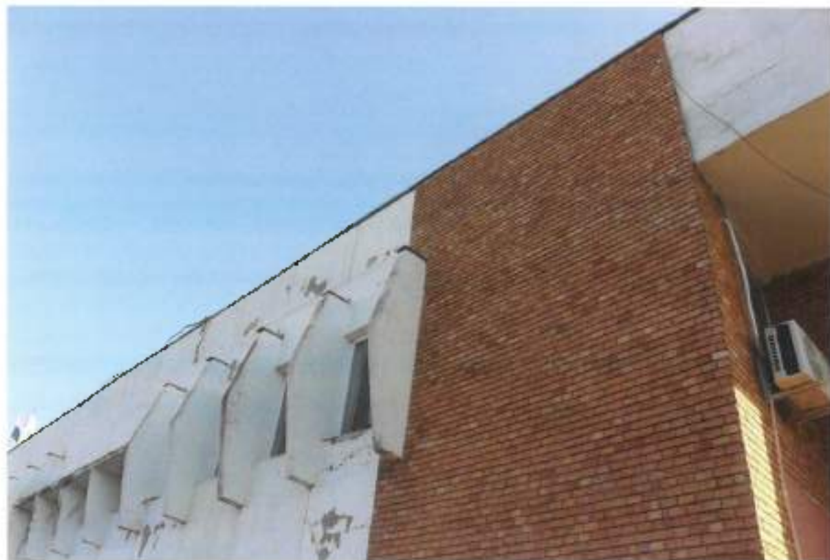
Foto B1 - Fațada principală
