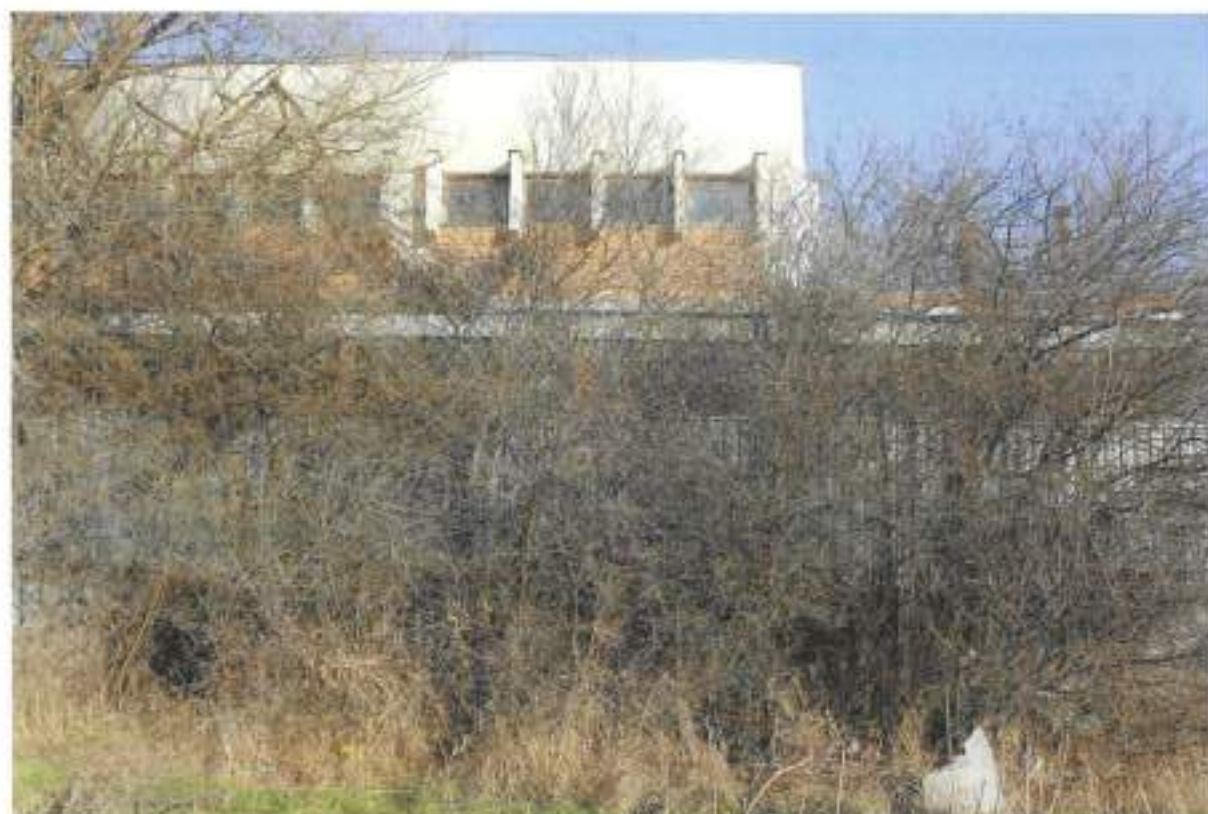
Foto 145 - Fațada laterală dreapta
