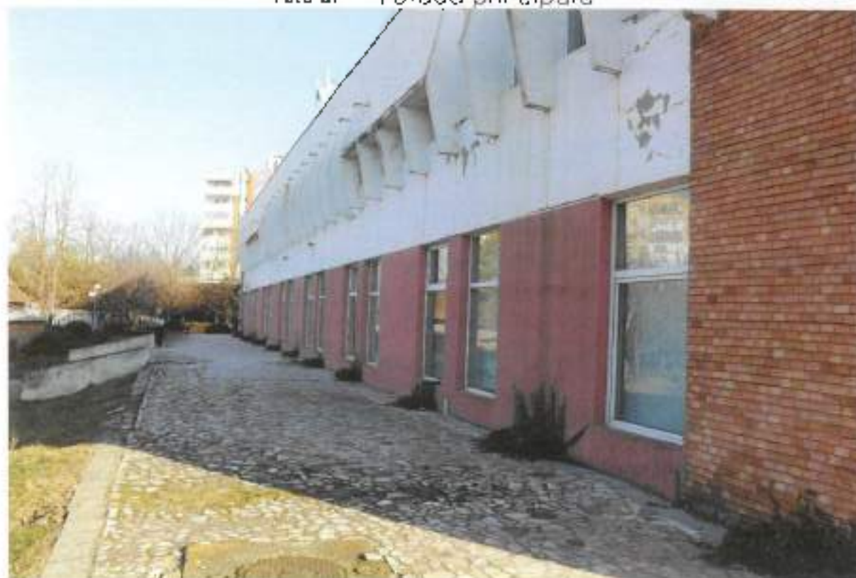
Foto B2 - Fațada principală
