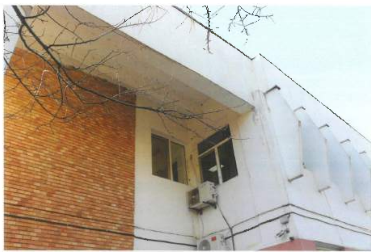
Foto 117 - Fațada laterală stânga
