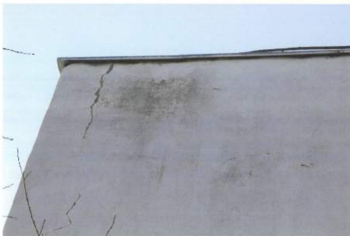
Foto 125 - Fațada laterală stânga
