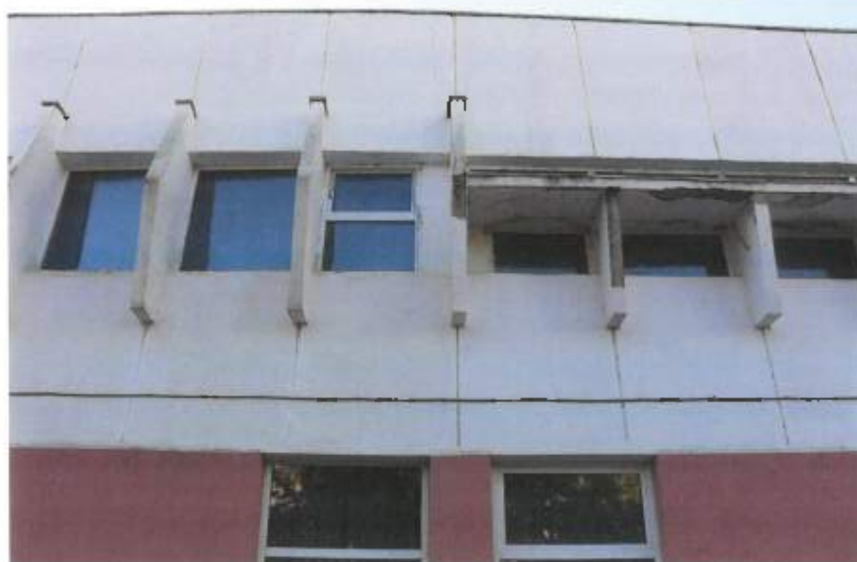
Foto 114 - Fațada laterală stângă
