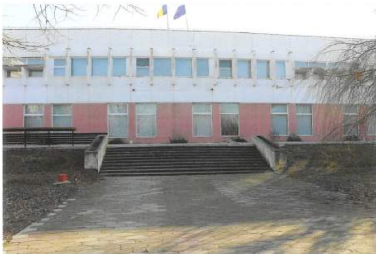
Foto B7 - Fațada principală
