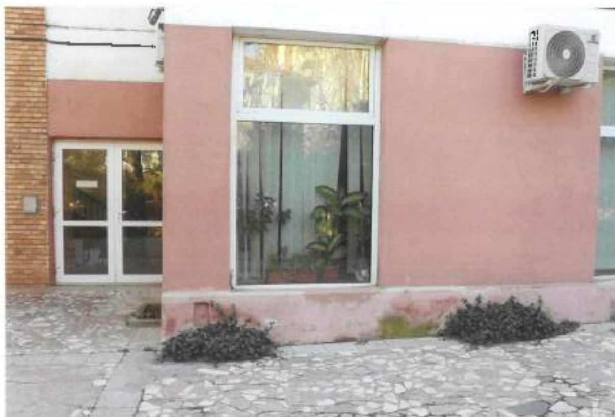
Foto 115 - Fațada laterală stângă
