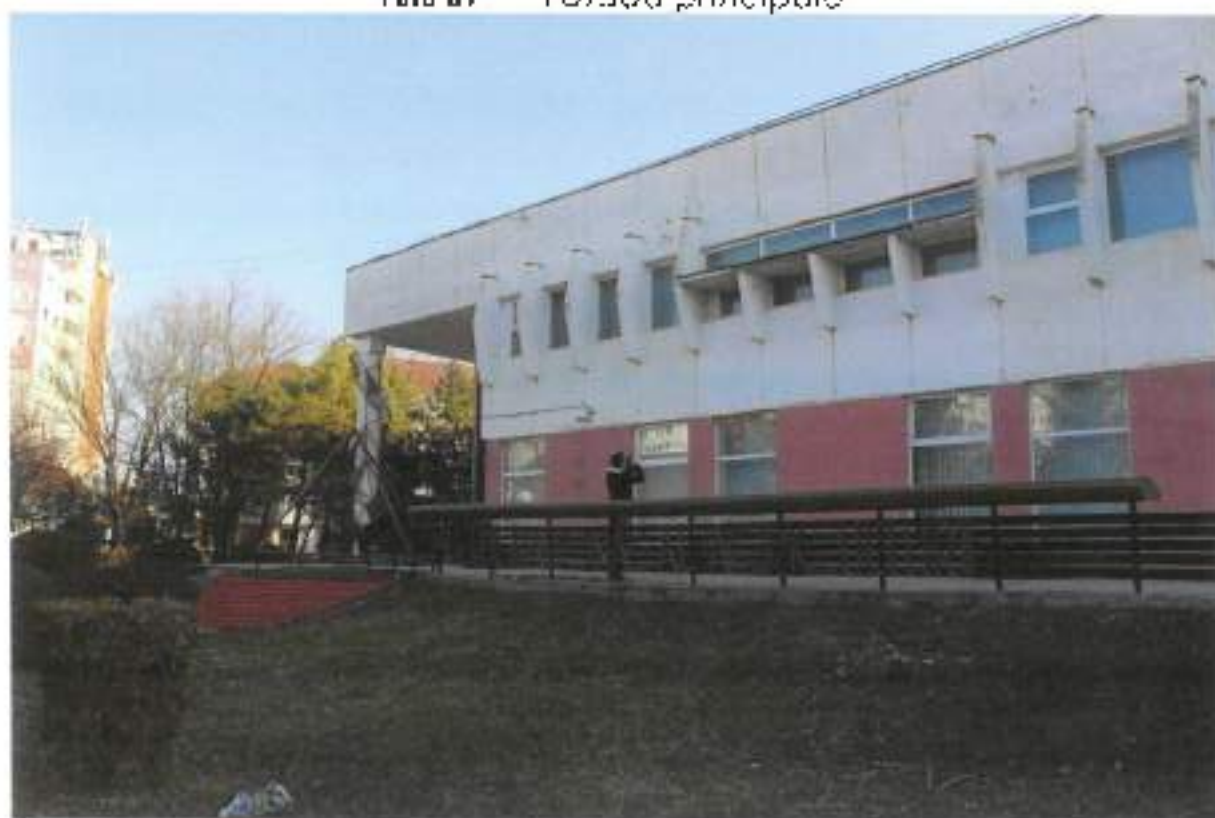
Foto B8 - Fațada principală
