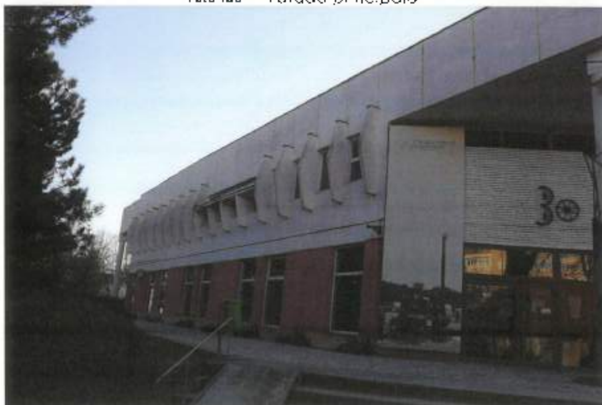
Foto 104 - Fațada laterală stânga
