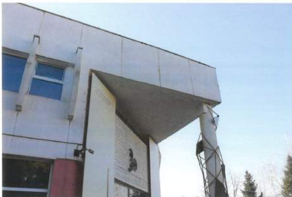
Foto 107 - Fațada laterală stângă
