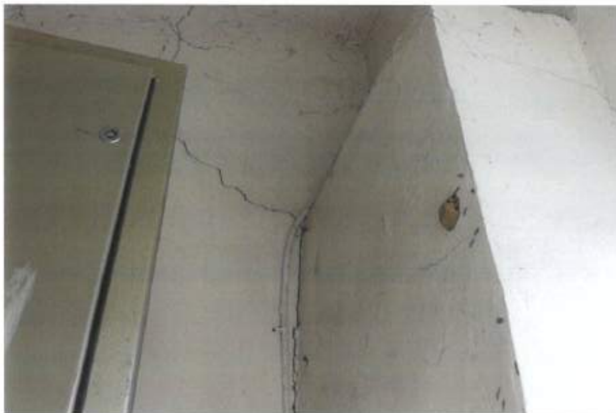
Foto 45 - Partea inferioară a unei pereți dintr-o încăpere a panoului electric general
