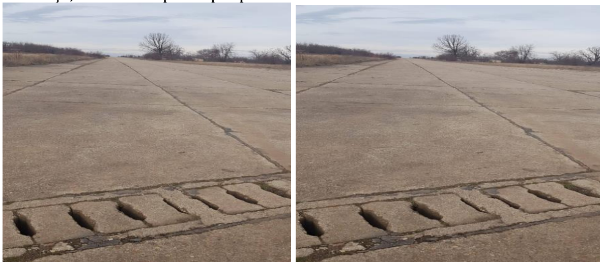
Figura 10 – Imagini canal pluvial
