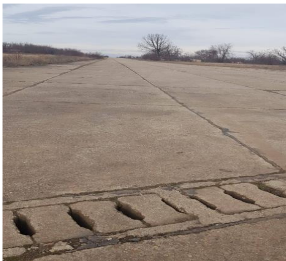
Figura 9 – Imagini canal pluvial
