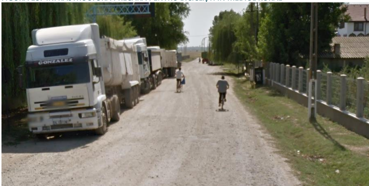
FIGURA 187 INFRASTRUCTURĂ PRECARĂ PENTRU BICICLIȘTI ÎN MEDIUL RURAL
