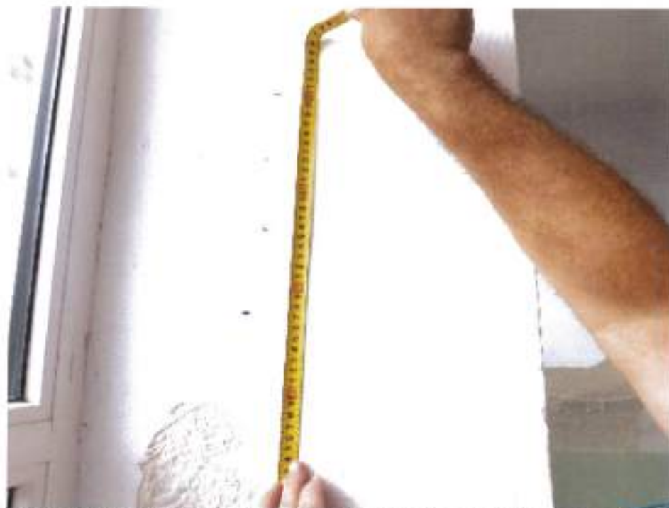
Măsurare dimensiuni stâlp; detectare număr, poziție și diametru armături transversale (etrier)
