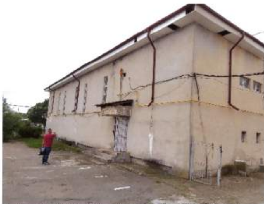
Sala de sport- fațadă principală și fațadă laterală dreapta: tencuiala exterioară la pereți și la soclu este degradată; burlanele evacuează apa prea aproape de clădire
