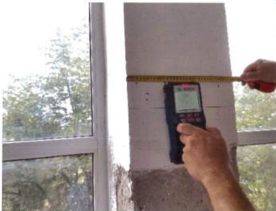
Măsurare dimensiuni stâlp; detectare număr, poziție și diametru armături longitudinale
