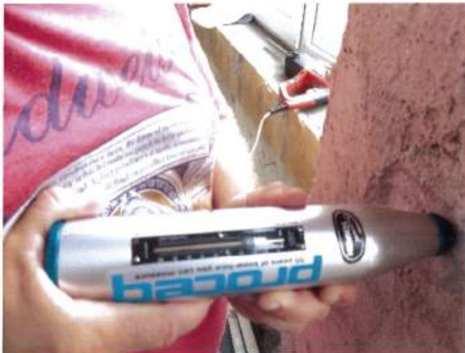
Clădirea școlii: Verificarea rezistenței la compresiune a betonului în stâlp, cu sclerometru mecanic
