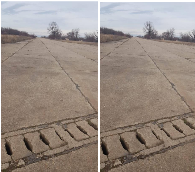
Figura 11 – Imagini canal pluvial
