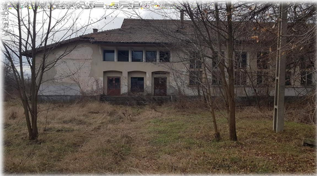
Figura 20 – Imagin imobil C10 - construcție Sala mese, P+S+M
