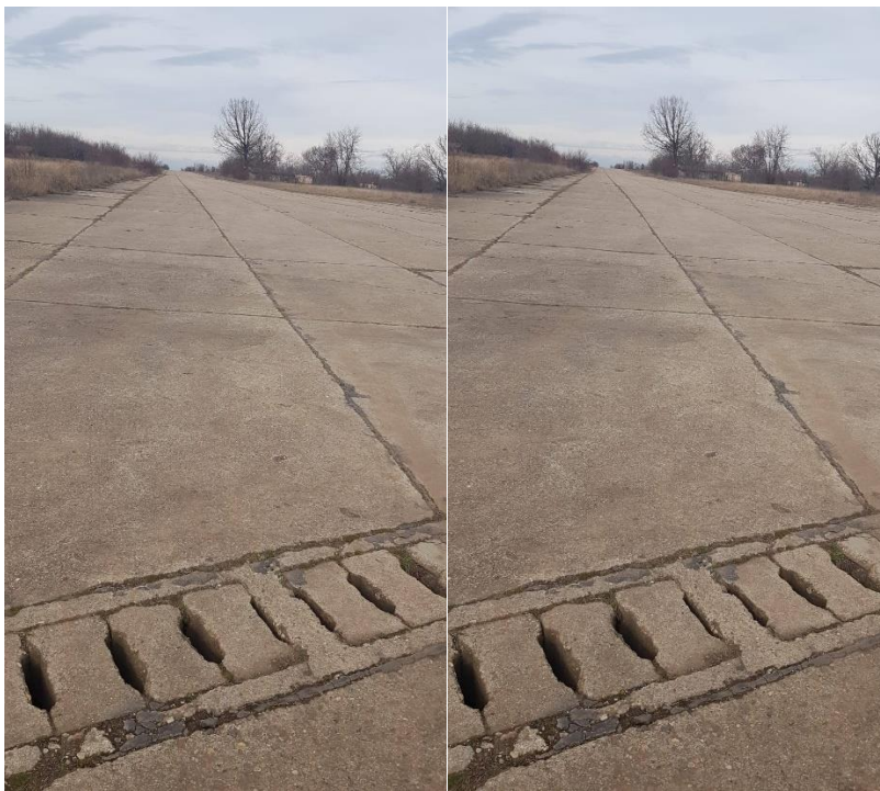
Figura 11 – Imagini canal pluvial
