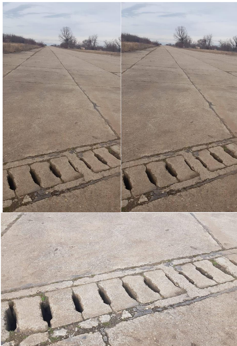
Figura 17 – Imagini canal pluvial
