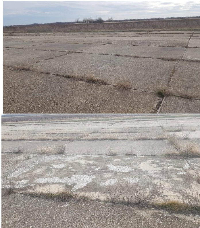
Figura 15 – Imagini pista betonată Alexeni
