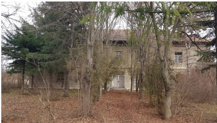
Figura 13 - Imagine imobil C16 - construcție Corp administrativ
