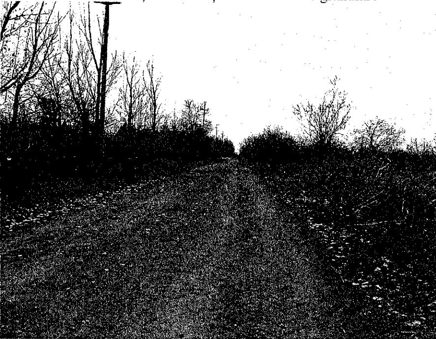
Foto nr.10 – Vedere strada Unității, după trecere la nivel CF, îmbrăcăminte bituminoasă degradată total, împietruire acoperită cu pământ prevenit din terenurile agricole stângă-dreapta
