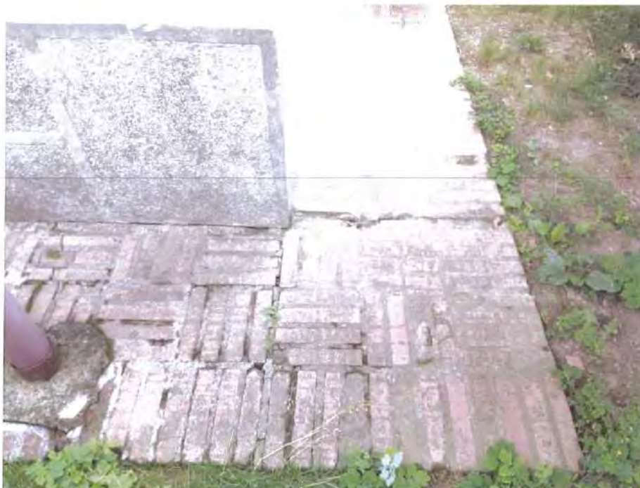
Trotuar perimetral: trotuarul este prea îngust și este fisurat, ceea ce permite infiltrarea apei la fundații
