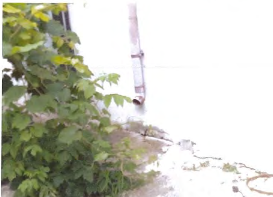
Rost neetanș între trotuar și clădire; burlanul este prea scurt și evacuează apa lângă clădire
