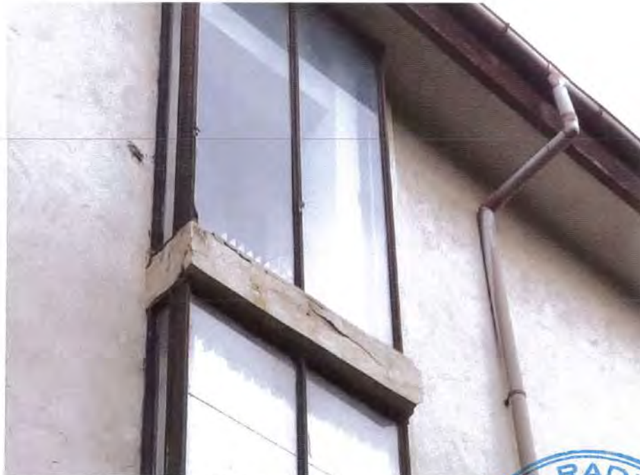
Corp B: Tencuială exterioară exfoliată
