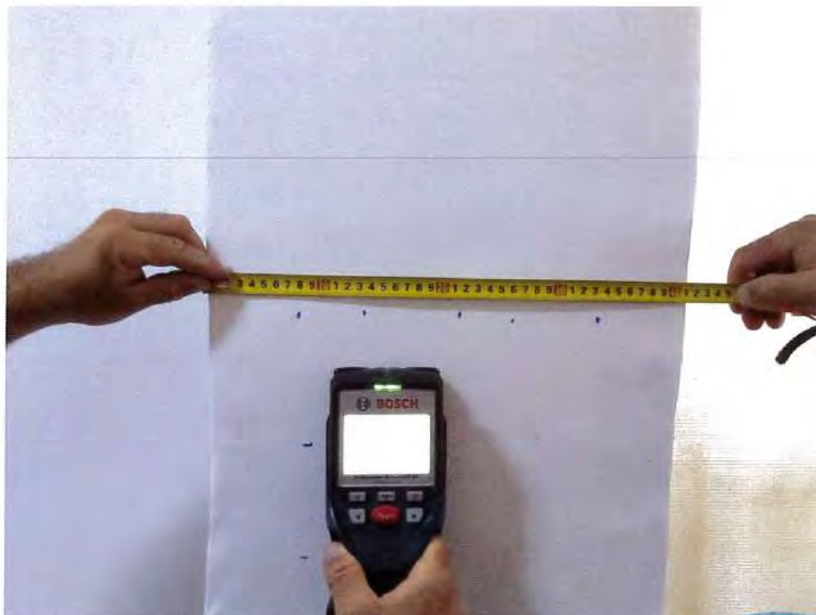
Măsurare dimensiuni stâlp; detectare număr, poziție și diametru armături longitudinale
