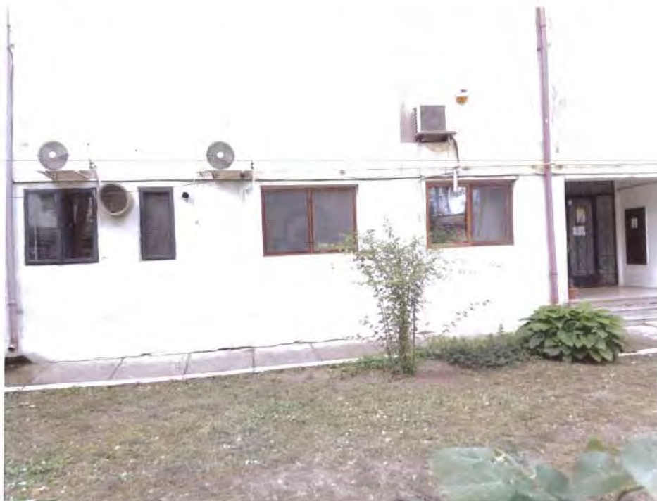
Corp B - Fațadă principală: rost neetanș între clădire și trotuar
