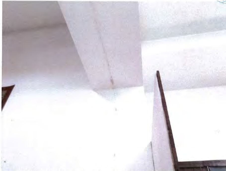
Finisaje interioare degradate la zona de rost dintre tronsoane
