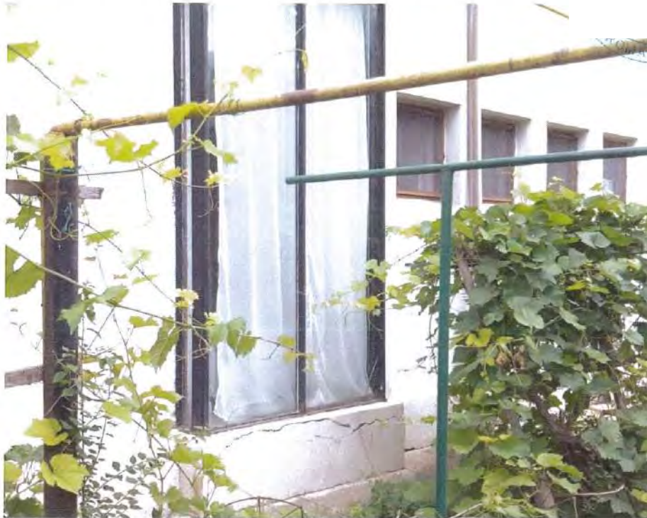
Corp B: Tencuiala soclului este fisurată și exfoliată
