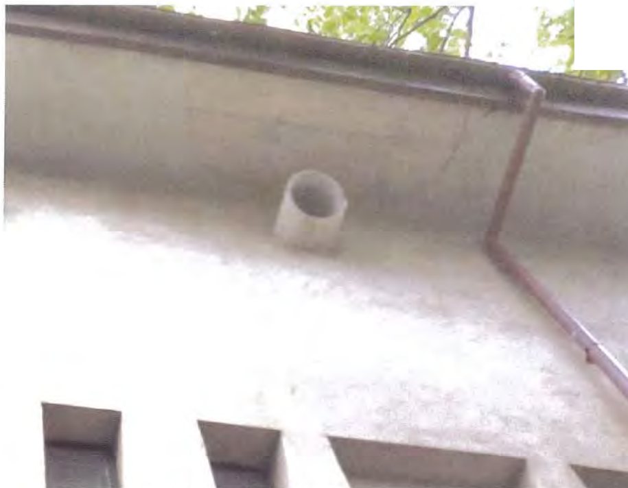
Corp B: tencuială căzută la intradosul streșinii din beton armat
