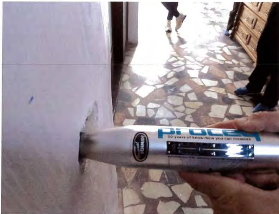
Verificarea rezistenței la compresiune a betonului în stâlp, cu sclerometru mecanic
