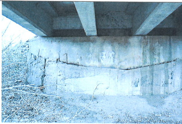
Foto 1 – degradări ale betonului – culeea 2
