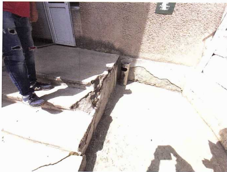
Tronson 1: finisaje degradate (tencuială exfoliată la soclu); trepte avariate
