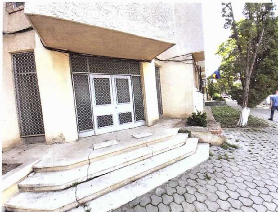
Tronson 1: finisaje degradate (tencuieli exterioare exfoliate; mozaic trepte fisurat)
