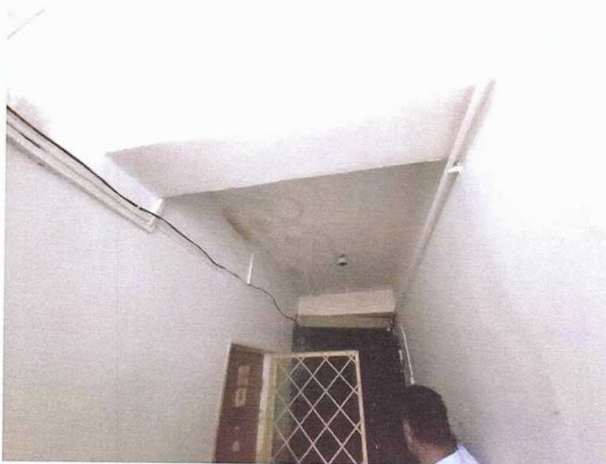
Tronson 1: finisaje interioare degradate din cauza infiltrațiilor prin acoperiș
