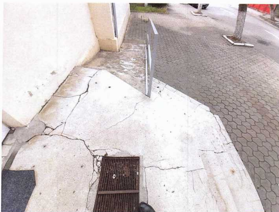
Tronson 2: finisajul treptelor este fisurat; trotuarul din pavele mici nu asigură etanșitatea în jurul clădirii
