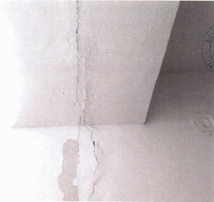
Finisaje interioare degradate la zona de rost între tronsoane
