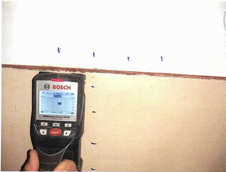
Verificare armare stâlpișor; detectare număr, poziție și diametru armături longitudinale
