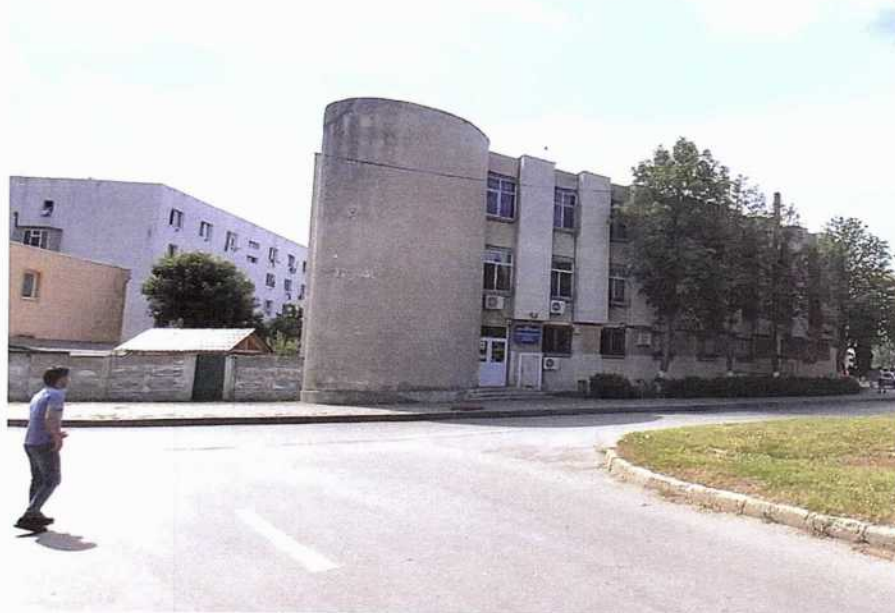
Tronson 1 – Fațada principală
