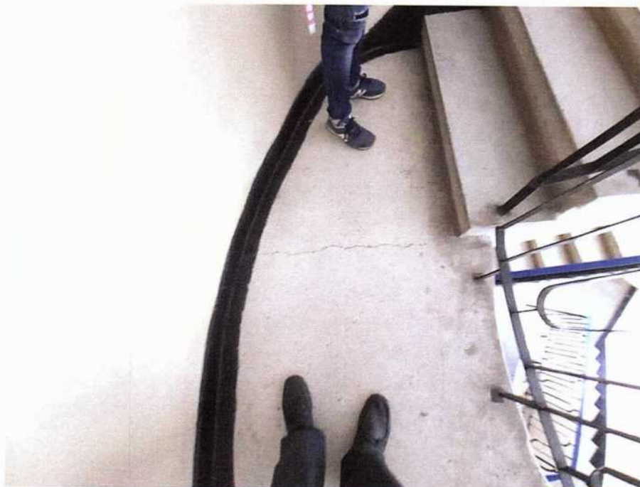
Tronson 1: fisură în mozaic podest scară ax 1/A
