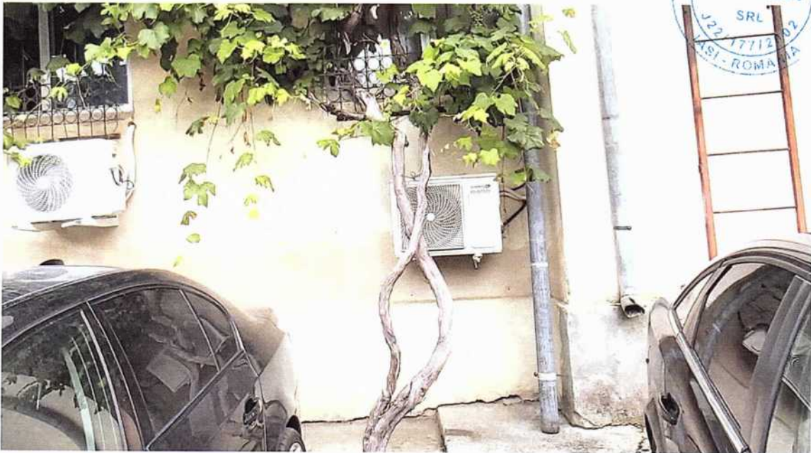
Tronson 1 – Fațada posterioară: rost neetans între trotuar și clădire; burlanul din partea dreaptă evacuează apa prea aproape de clădire; burlanul din partea stângă nu este funcțional
