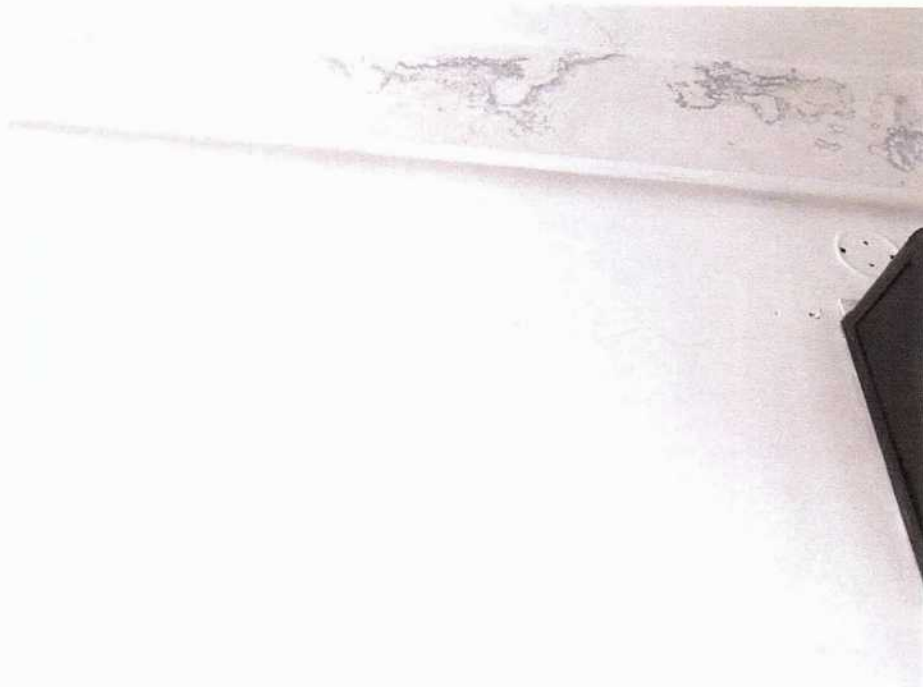
Finisaje interioare degradate (zugrăveli și tencuieli exfoliate)
