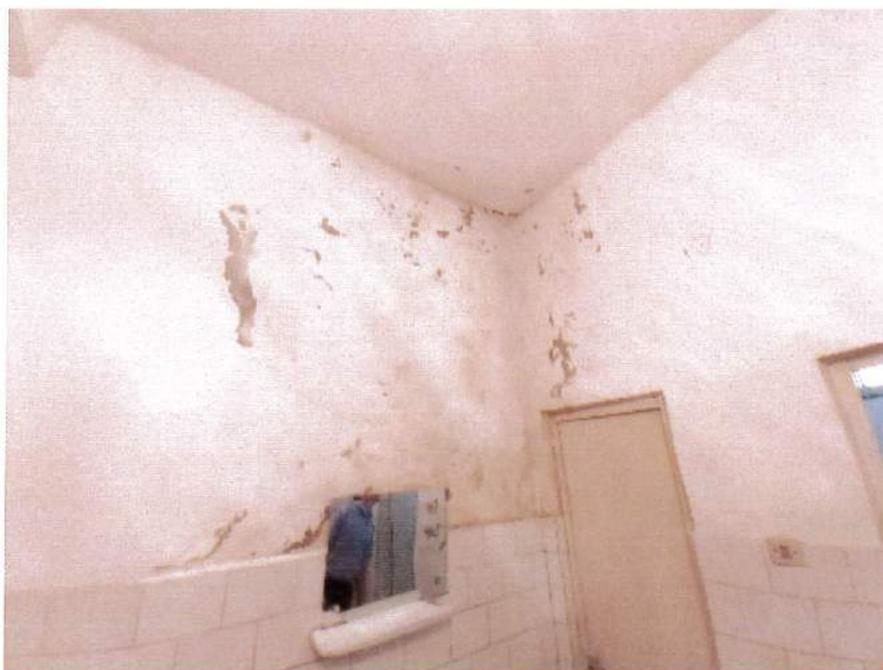
Degradări ale finisajelor în grupul sanitar de la etajul 2 (zugrăveli și tencuieli exfoliate) din cauza infiltrațiilor prin acoperiș și a ventilației necorespunzătoare
