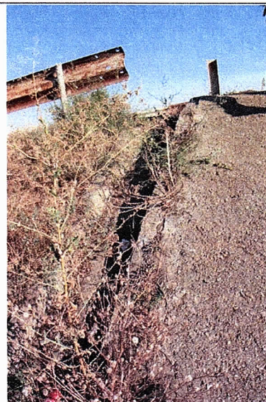
Foto Nr. 14 Detaliu casiu: percu degradat, șant necuratat, acoperit cu vegetație.
