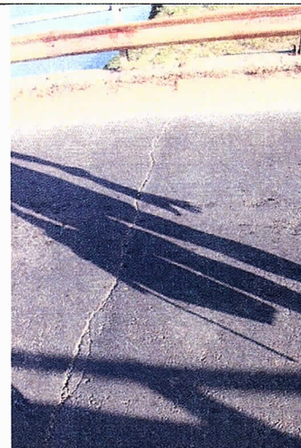
Foto Nr. 16 Vedere la nivelul caii: crăpătura transversala pe toata latimea caii, în dreptul unui rost de dilatație.
