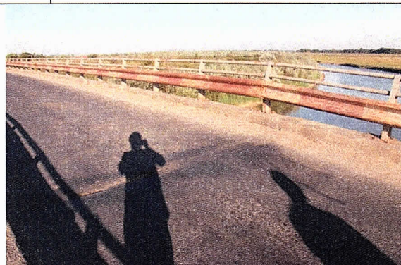
Foto Nr. 17 Vedere la nivelul caii: crăpătura transversala pe toata latimea caii, în dreptul unui rost de dilatație.
