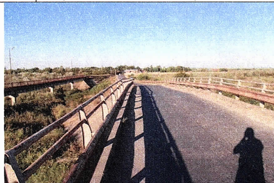
Foto Nr. 18 Vedere la nivelul caii: podul nu este racordat în plan vertical cu linia roșie de pe rampe.
