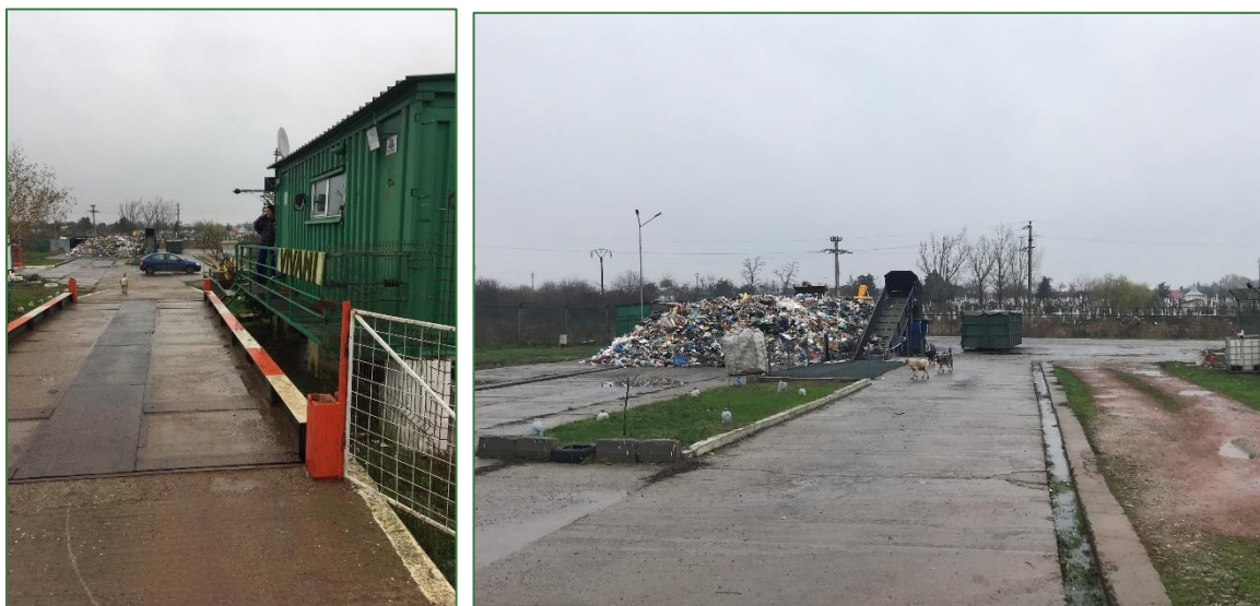
Figura 4-5: Stația de transfer Urziceni
